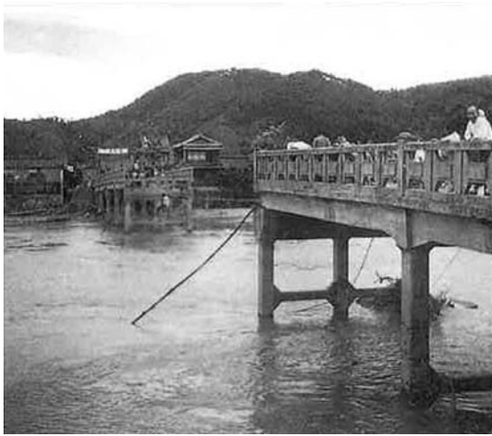
大和橋落橋の跡
