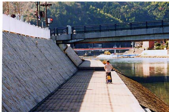
大和橋右岸アンダーパス(散策道)
