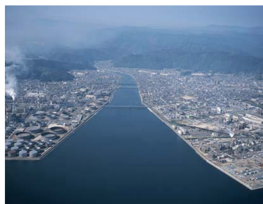
河口部 河口部には干拓地・埋立地が広がり、工業地帯となっている。
