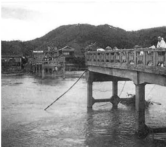
大和橋落橋の跡
