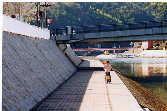
大和橋右岸アンダーパス(散策道)
