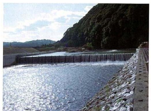
写真 4-15(3) 大井手堰（平成 17 年 1 月完成）
