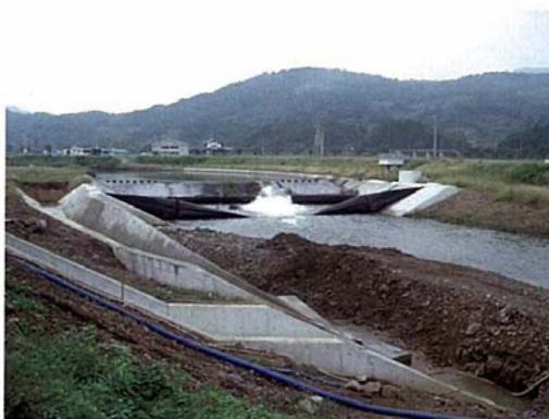
写真 4-15(2) 小井手堰（平成 17 年 3 月完成）
