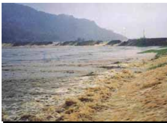
堤防からの越水状況 （小城市牛津町納所地区）
