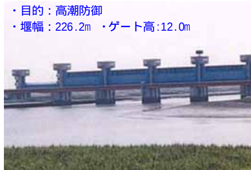
写真4-10 六角川河口堰(昭和58年3月完成)
