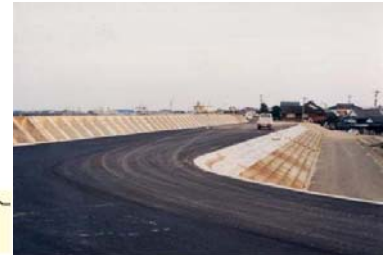
写真 4-14 高潮堤防の整備
