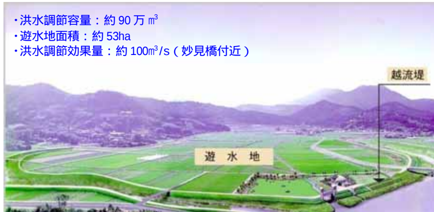
写真4-12 牟田辺遊水地（平成14年6月完成）
