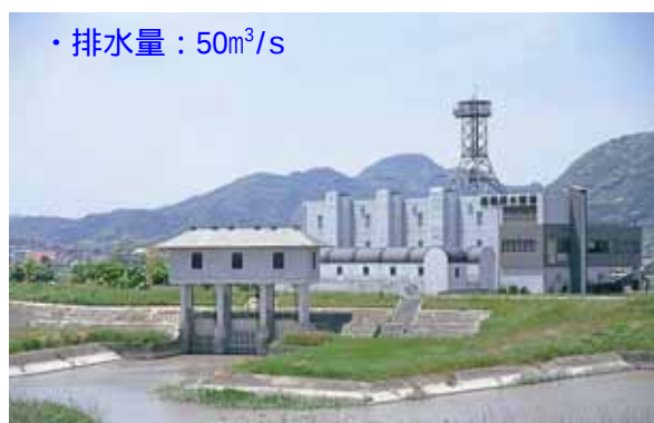
写真 4-13 高橋排水機場(平成9年3月完成)
