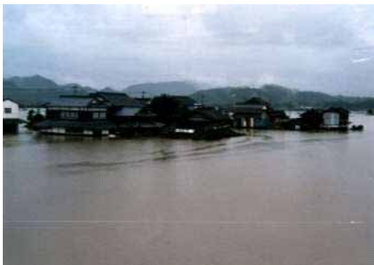
写真 4-7 武雄市橘町の浸水状況(H7.7)
