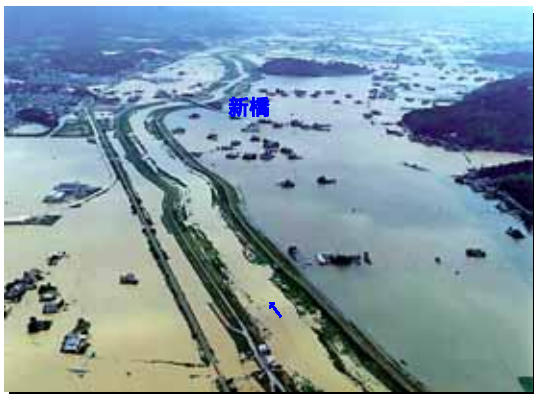
六角川新橋周辺浸水状況 （武雄市北方町志久・芦原地区）
