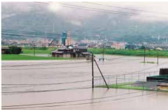
写真 4-6 多久市の浸水状況(H5.8)
