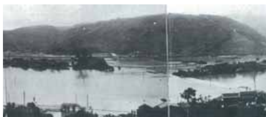
写真 4-3 多久市東多久町浸水状況 ( 皆木・別府地先 )
