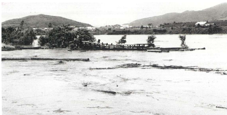
冠水した大和田地区
