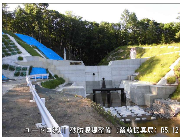
写真 2-1 ユードロ沢川 砂防堰堤整備
