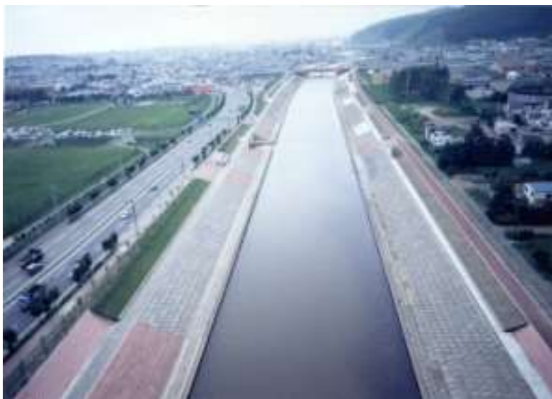
▲写真－４ 河道状況（下流部）
