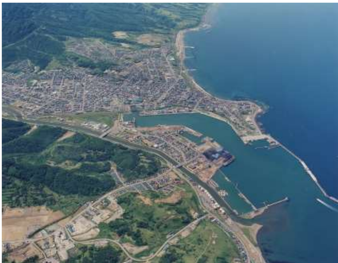
▲写真－１６ 留萌市街部における留萌川と鉄道・国道の状況
