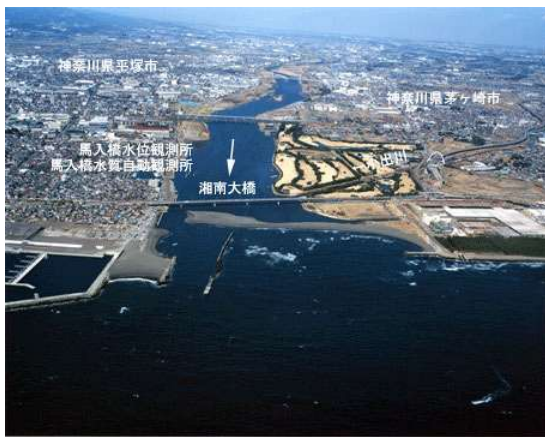
0km 湘南大橋
