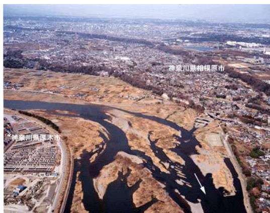
23km 磯部頭首工上流
