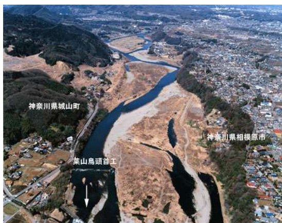
31km 葉山頭首工上流
