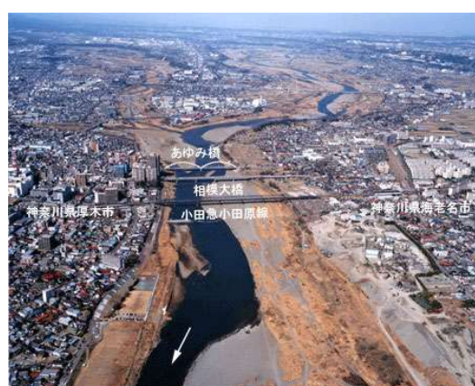
14km 相模大橋
