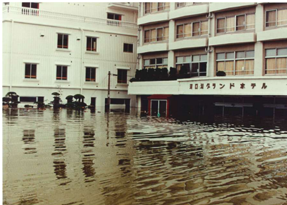
写真 4-2 昭和 58 年 8 月洪水浸水被害状況(大池地区)
