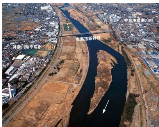
8km 東海道新幹線橋梁
