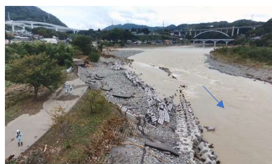
相模原市緑区大島 護岸被災状況
