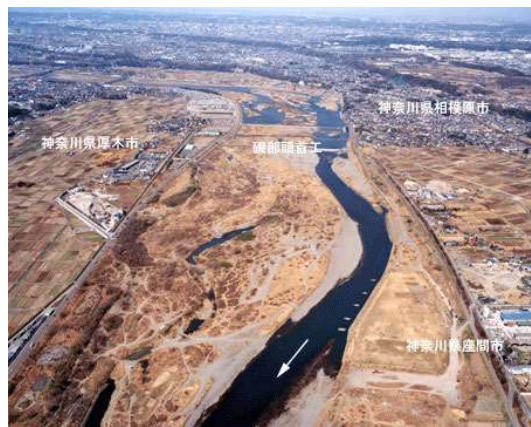
21km 磯部頭首工下流
