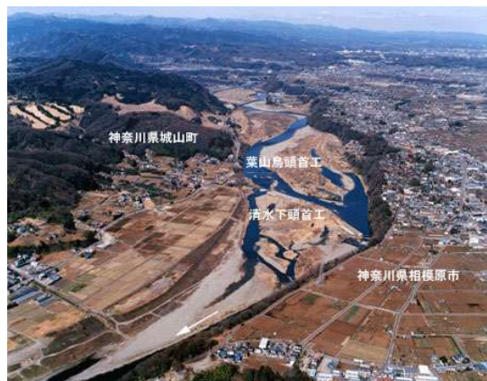
30km 葉山頭首工
