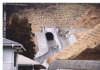
写真 4-6 嘯放水路吐口部(富士河口湖町浅川)
