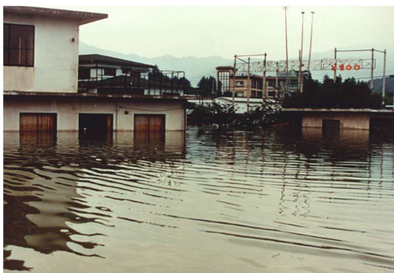
写真 4-3 昭和 58 年 8 月洪水浸水被害状況(大池地区)
