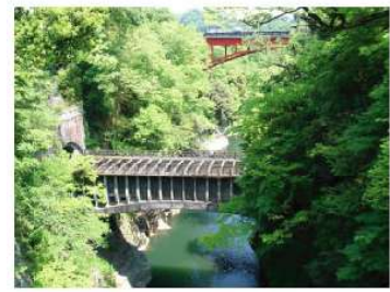
写真 2-24 八ッ沢発電所第1号水路橋 (有形文化財)
