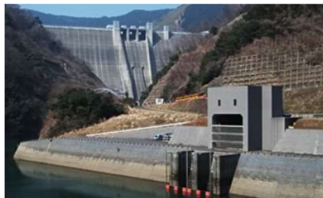
津久井導水路(呑口)
