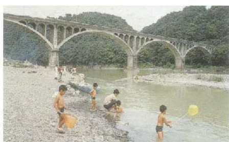
⑨美しいアーチの小倉橋 昭和13年完成のコンクリート造りのアーチ橋。相模川が穏やかな様相で流れ始める場所で、アユの釣り場でもある。
