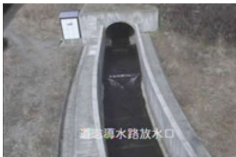
道志導水路(放水口)
