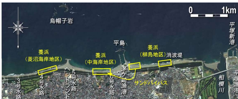
図 6-9 養浜材の投入箇所(神奈川県提供)
