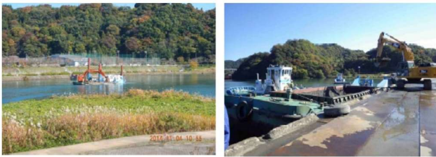
図 3-2 相模ダム浚渫の実施状況
