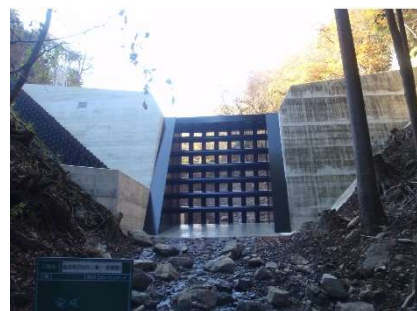
相模川水系 金波美沢砂防堰堤 [透過型砂防堰堤, R4 完成]
