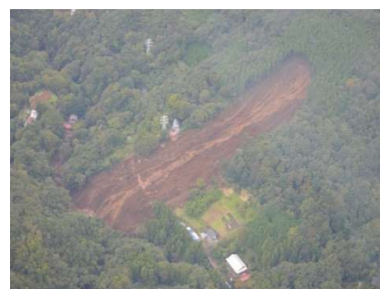
平成23年台風第12号で生じた深層崩壊 (山梨県大月市)
