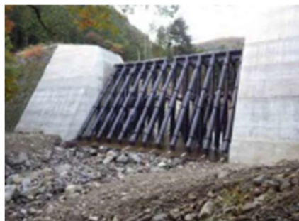
相模川水系 笹子川・滝子川砂防堰堤 [透過型砂防堰堤, H23.3 完成]
