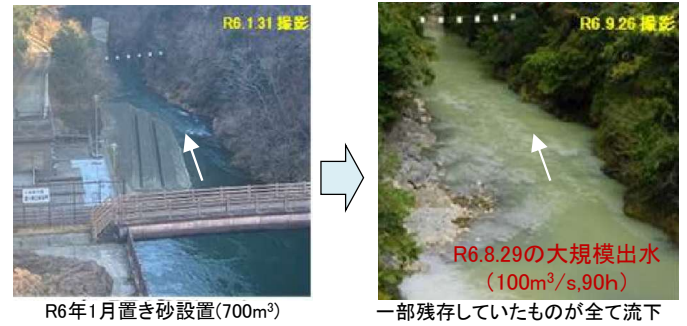
置き砂の設置・流出の状況(令和6年度)
