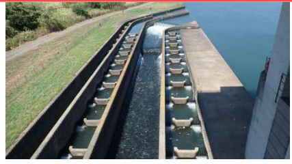
相模大堰の魚道
