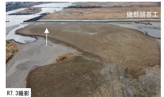
河道掘削及び樹林化対策(磯部頭首工上流)
