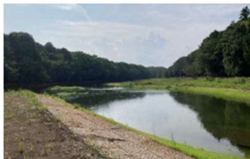
雨水貯留施設(藤沢市)
