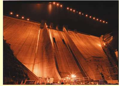
ダム下流面から見た夜景(H6)
