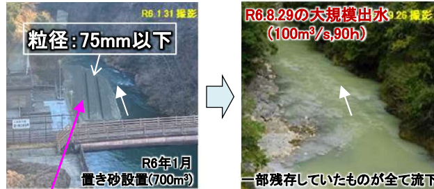
置き砂の設置・流出の状況(令和6年)
