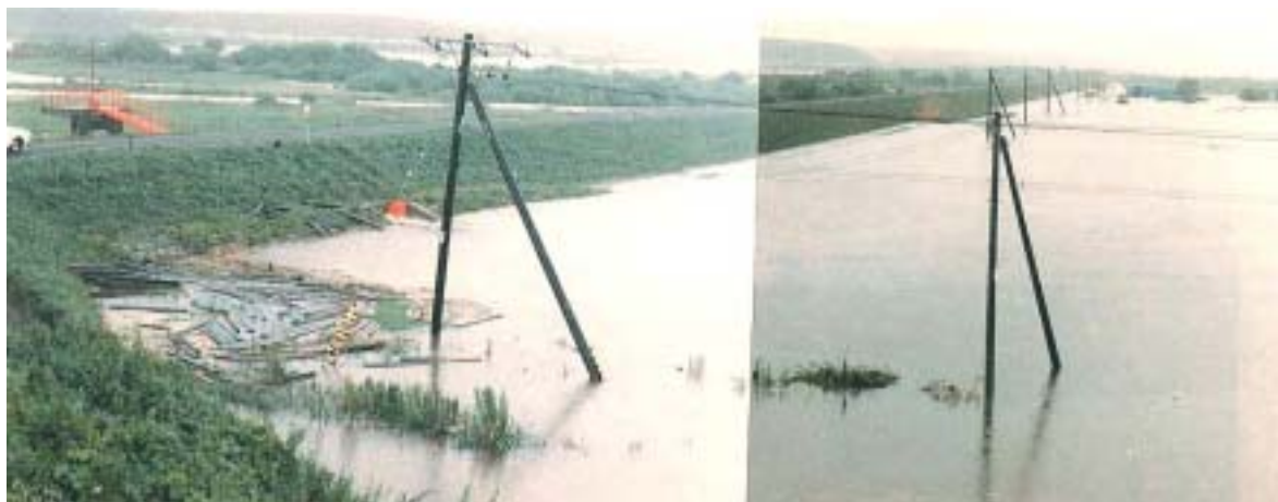
沙流川左岸富浜樋門付近一帯内水氾濫・門別町（昭和 56 年 8 月）
