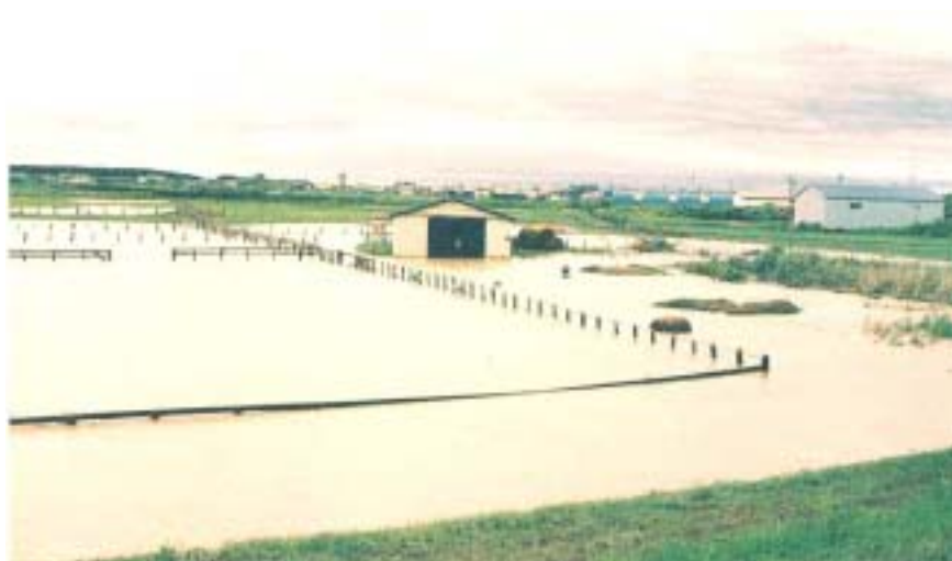
KP 0/3 右岸内水氾濫状況（平成 4 年 8 月）
