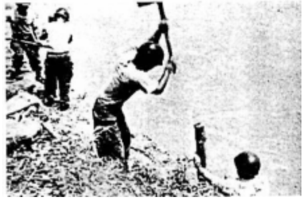
必死の護岸作業を行う自衛隊員・広報びらとり (昭和36年7月)
