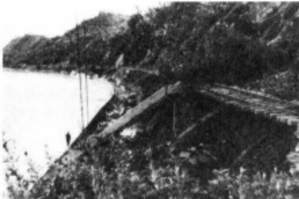
台風9号による国鉄富内線の鉄道崩落現場 ・昭和37年8月(日高町史)
