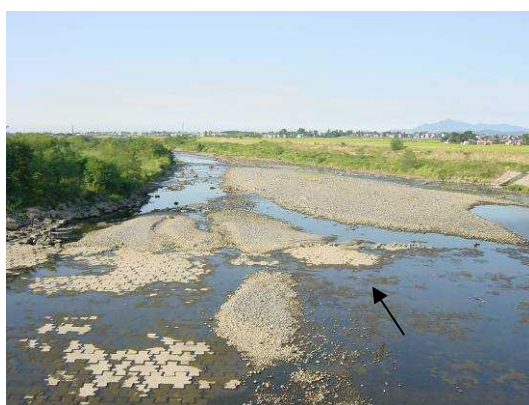
関川頭首工より下流を望む（妙高市）
