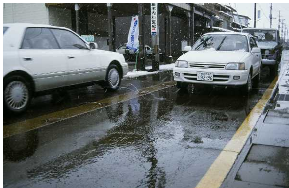
道路に散水される消流雪用水
