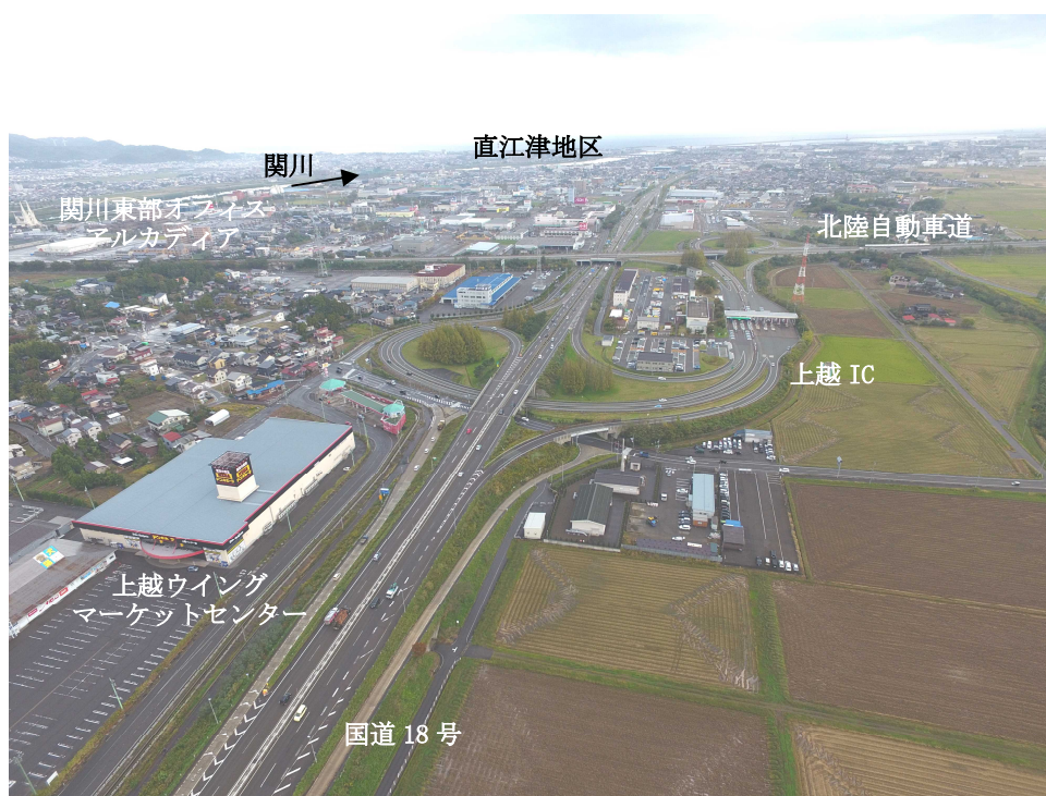
北陸自動車道上越インターチェンジ周辺の立地状況（平成 30 年（2018 年）10 月撮影）
