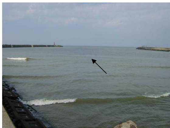
下流部河口付近
