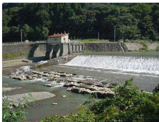
板倉発電所取水堰堤
