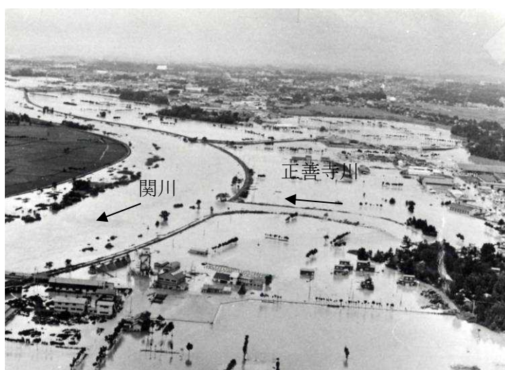
春日山橋上流の氾濫状況（上越市木田 きだ 地先）
