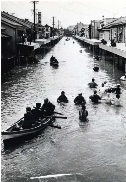
直江津駅前浸水状況
