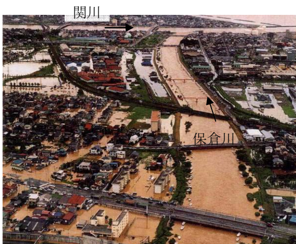
上越市春日新田地先浸水状況
