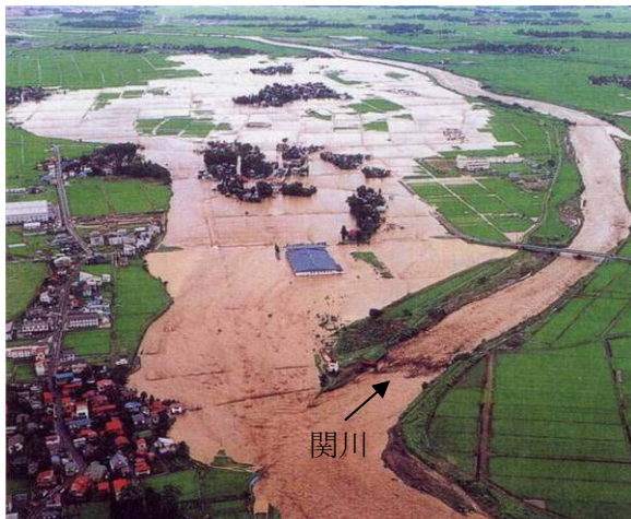
新井市月岡地先破堤状況
