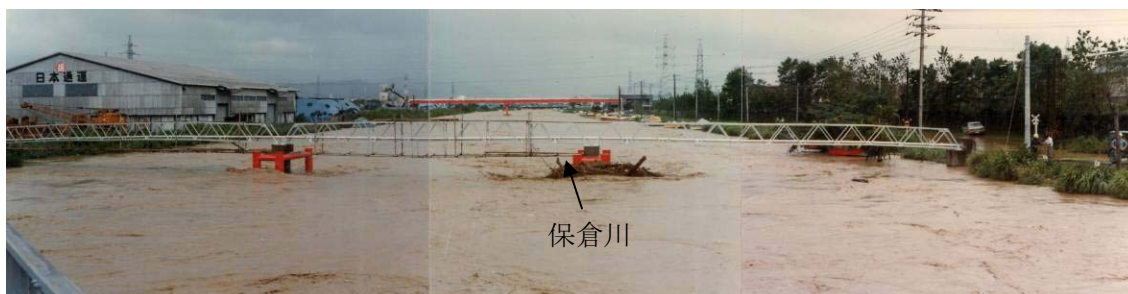
JR 保倉川橋梁より下流を望む
