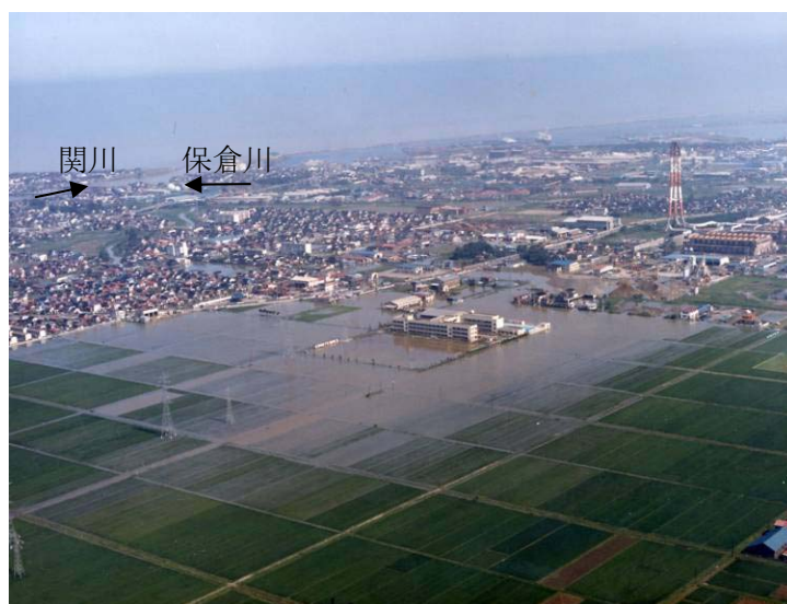
上越市福田地先湛水状況
