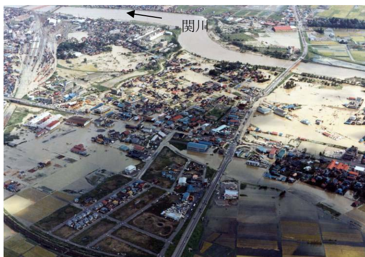
上空より関川大橋を望む
