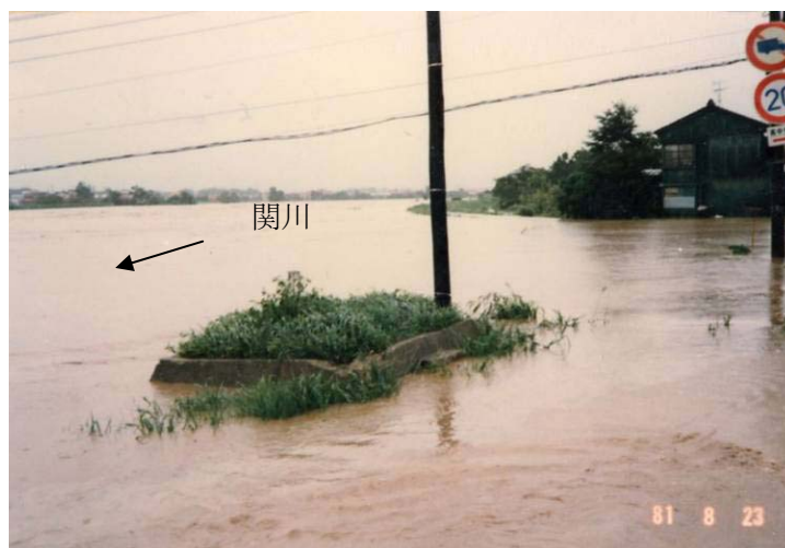
稲田橋上流左岸溢水状況（北城町付近）
