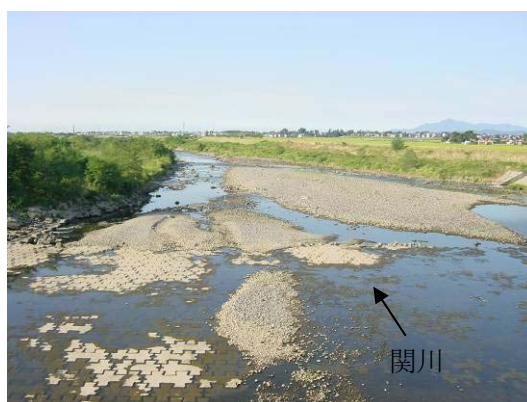
関川頭首工より下流を望む（妙高市）
