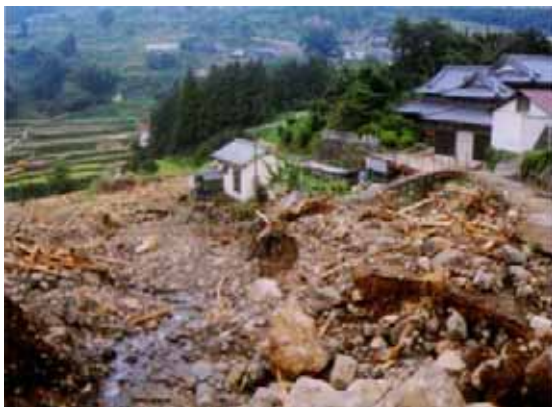
平成 11年 9月洪水での土砂災害 (惣田谷川 そうだたにがわ )
