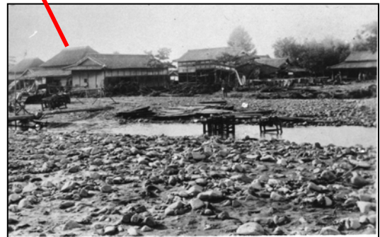
重信川の破堤による田畑への川砂利の流出（松山市久谷地区）
