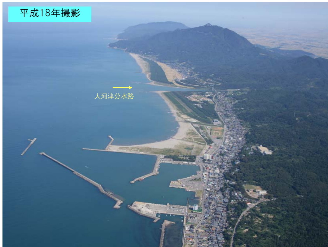
図 5-2 現在の大河津分水路河口の状況
