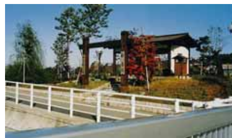
妙見堰広場（番所跡に建設されている） （信濃川・魚野川五十三次マップ）
