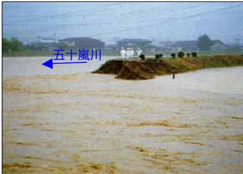
写真 4-42 五十嵐川の破堤状況
