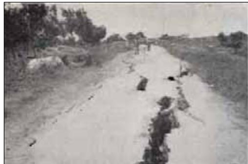
写真5-10 横田地先の堤防亀裂
