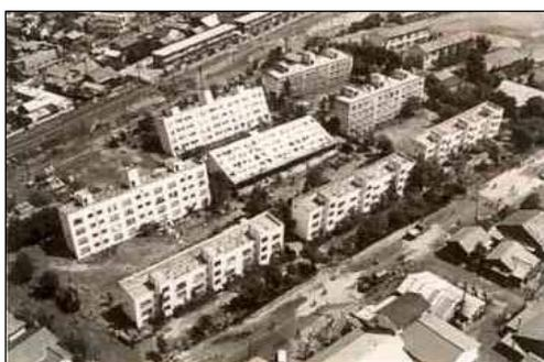
写真5-1 液状化により傾いた県営アパート
