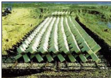
写真 4-70 導流堤設置状況
