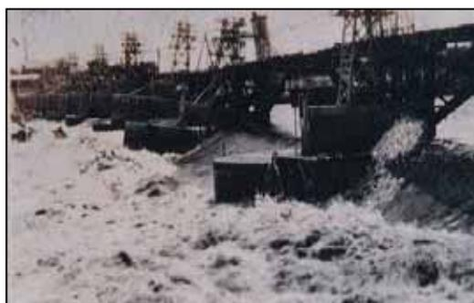
写真 4-63 陥没した自在堰
