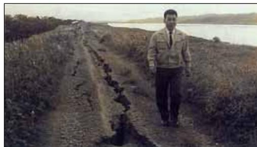
写真5-11 真野代地先の堤防亀裂
