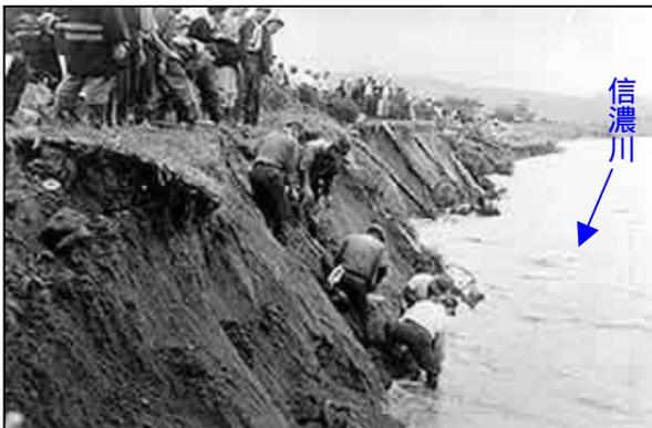
写真 4-15 長岡水梨地区の堤防欠壊状況
