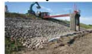
写真 5-22 町軽井堤防復旧工事
