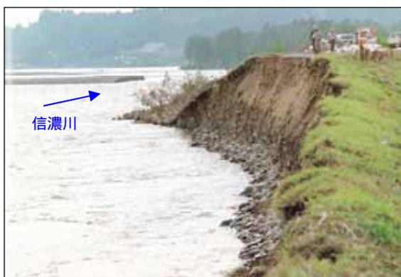
写真 4-33 十日町高島地先での堤防欠壊状況
