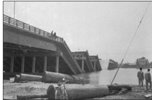
写真5-4 地震により落下した昭和大橋
