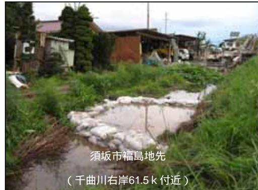
平成18年7月洪水堤防漏水状況
