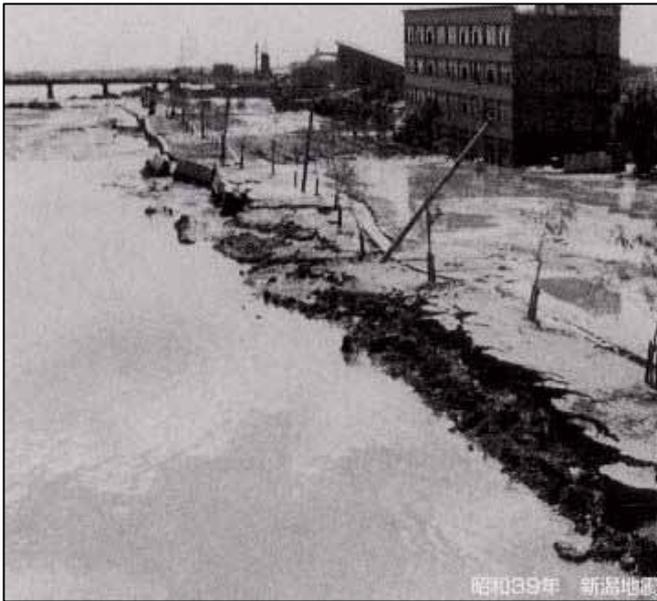
写真5-7 地震と津波により流出した堤防
