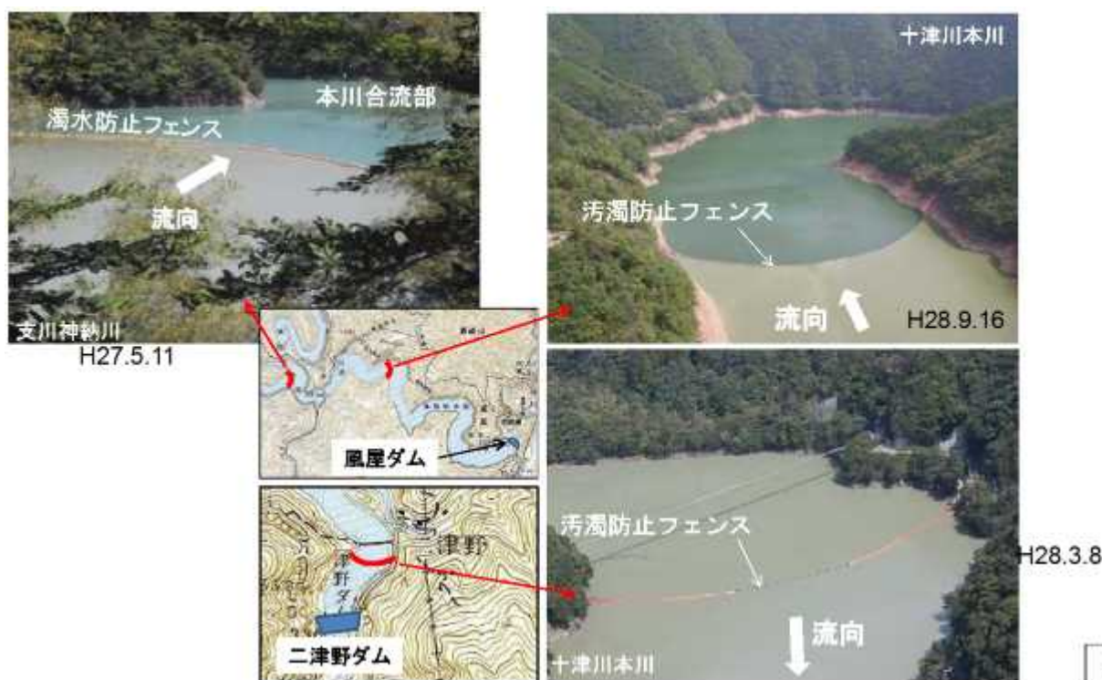
図 8-8 風屋ダム・二津野ダム 濁水防止フェンスの設置状況
