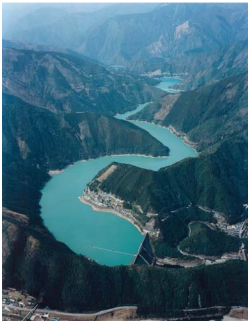
風屋ダム付近（奈良県十津川村）
