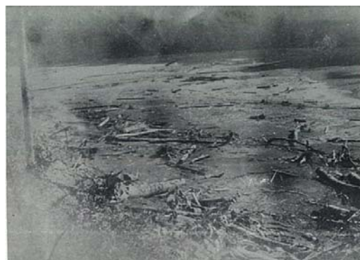
大字川津付近、洪水による家屋喪失
