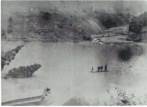
大字林山崩れ、十津川を閉塞
