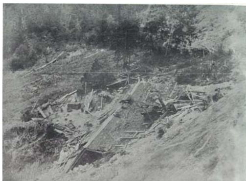
大字小森の山崩れ、家屋崩壊
