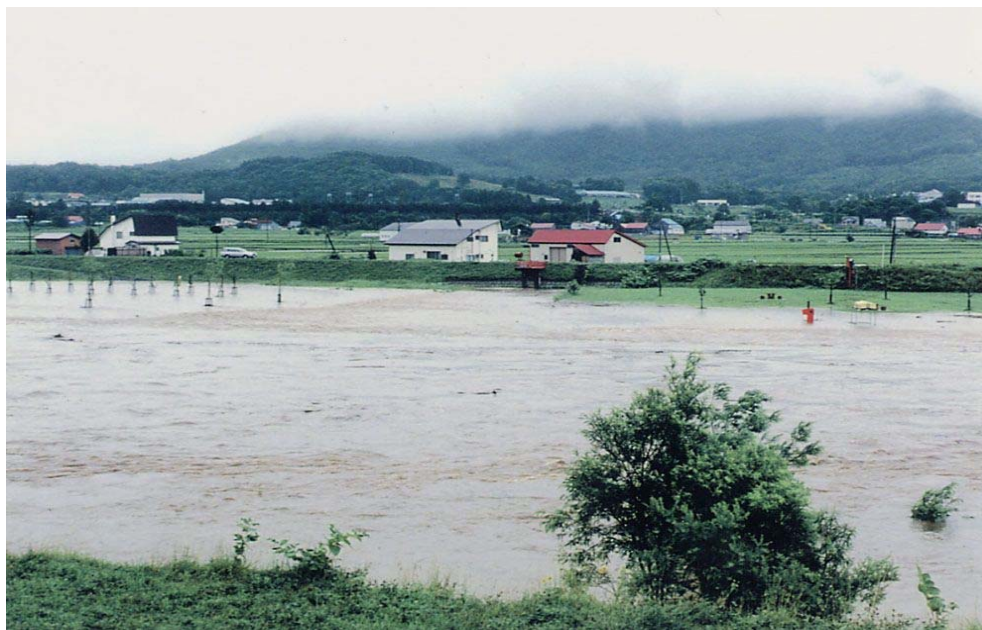
平成 11 年洪水 旧蘭越 2 号樋門付近の状況
