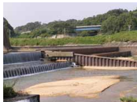
鈴鹿川第二頭首工魚道の状況
