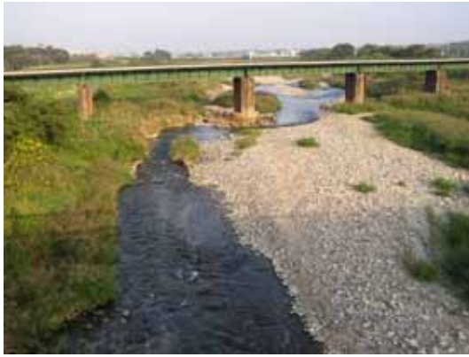
砂礫河原（亀山橋下流）
