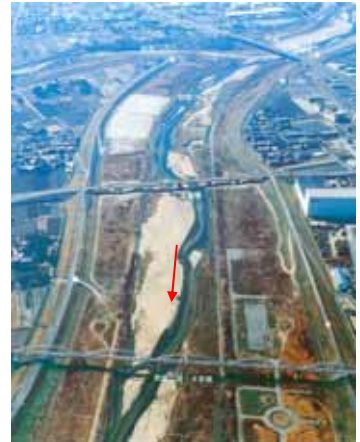
鈴鹿川下流部（4km 付近） 鈴鹿川派川を分派し、緩やかに蛇行しながら流下している。
