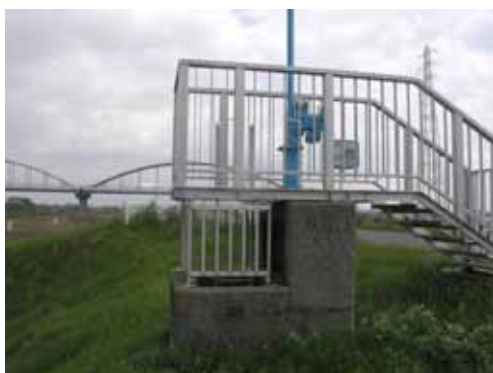
北一色用水樋管
