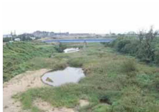
近鉄名古屋線派川橋梁
