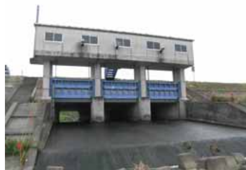
管内排水樋門
