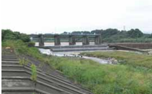
鈴鹿川第二頭首工
