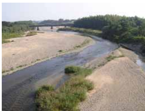
砂礫河原と河畔林（安楽川 1.0k 付近）
