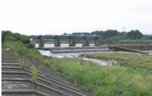
鈴鹿川第二頭首工 河川名：鈴鹿川 位 置：9.6k+175.0m 完成年：昭和 31 年
