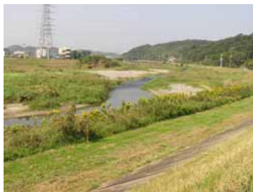
砂礫河原（内部川 3.6k 付近）
