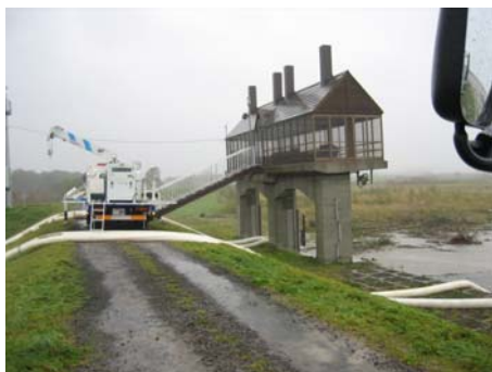
写真 4-4 渚滑右岸樋門 内水排除状況
