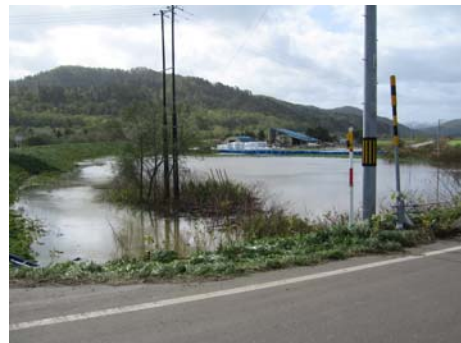
写真 4-5 ウツツ地区の内水氾濫状況
