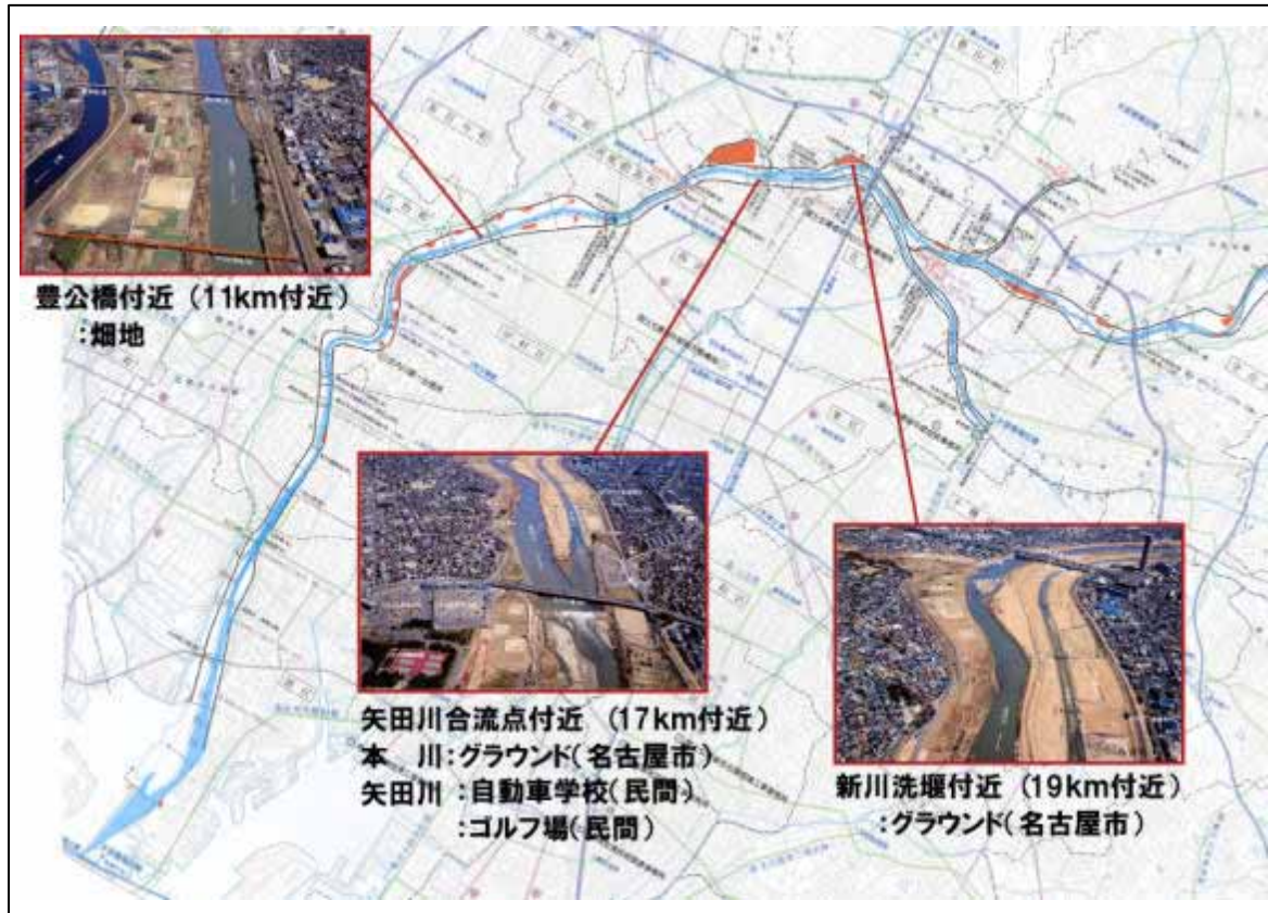
図-7.14 高水敷の利用状況(下流)
