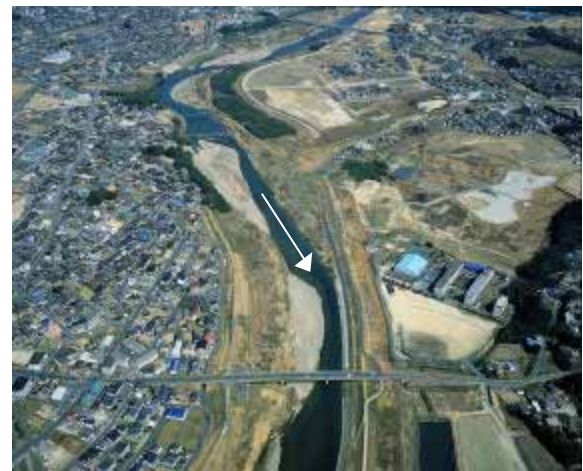
野添川合流付近(33.0k 付近)
