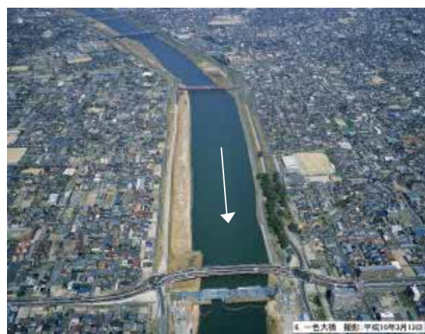
一色大橋(4.5k 付近)
