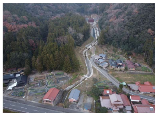
図 2-3 島根県による砂防施設の整備事例（砂防堰堤、溪流保全工）
