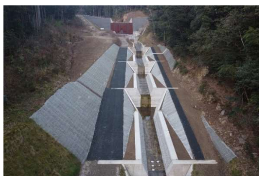
図 2-3 島根県による砂防施設の整備事例（砂防堰堤、溪流保全工）
