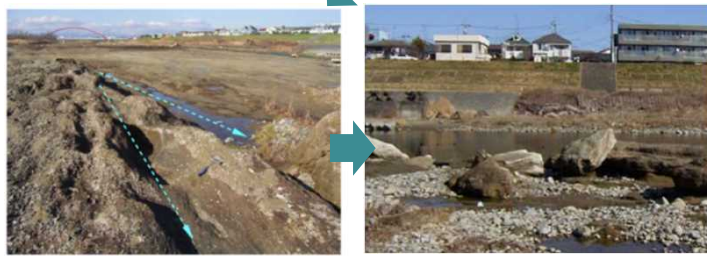
縦断方向に溝状侵食を形成
