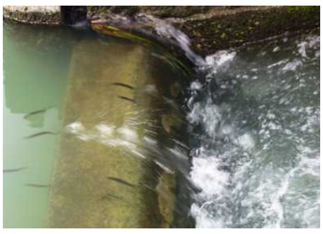
魚道を遡上するアユ(調布取水堰)
