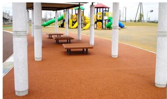
福島親水公園（支川西川沿い）の瓦廃材利用透水性樹脂舗装
