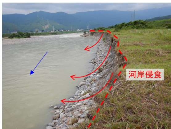
能美市灯台笹地先の河岸侵食
