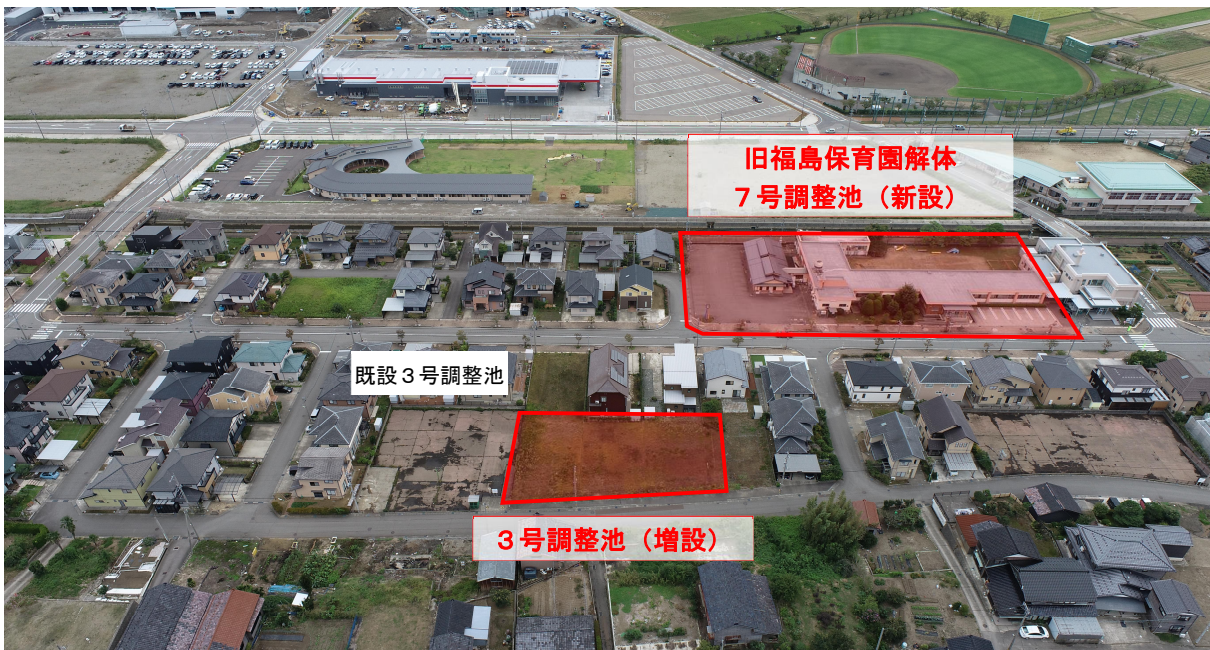
図 4-17 雨水調節施設：調整池
