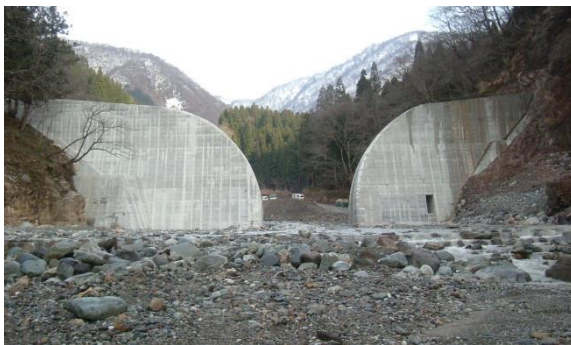
尾添川砂防堰堤（平成20年1月竣工）
