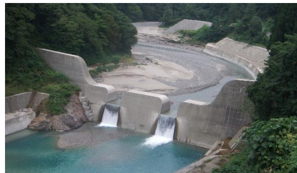
瀬戸砂防堰堤（平成26年3月竣工）
