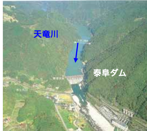
泰阜ダム付近の状況
