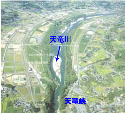
天竜峡付近の状況
