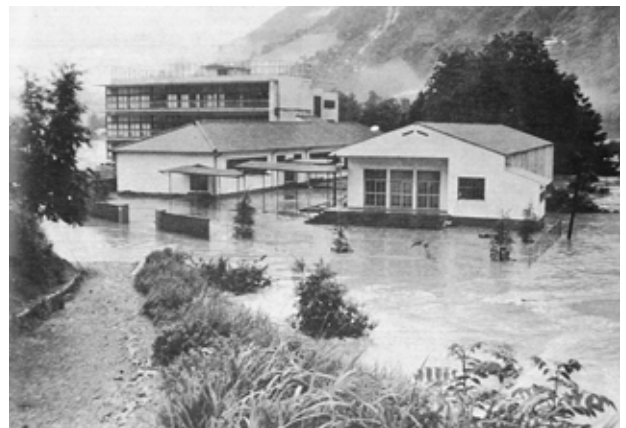
浜松市佐久間小学校の浸水状況
