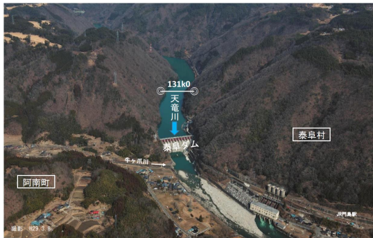
泰阜ダム付近の状況
