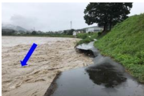
天竜川左岸 208.2k 付近 河岸侵食
