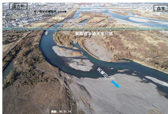
東海道線下流部付近の状況
