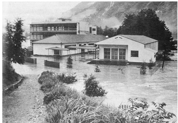
浜松市佐久間小学校の浸水状況
