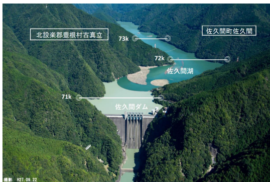
佐久間ダム付近の状況
