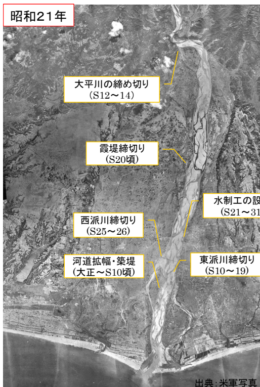
過去の改修状況
