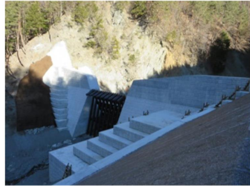
持社沢砂防堰堤 (H27年度完成)(小渋川流域)
