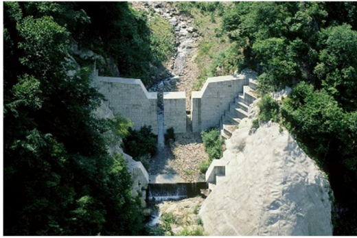
地獄谷 スリット型砂防堰堤 (H15年度完成)(小渋川流域)
