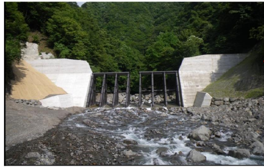
梶谷第4砂防堰堤 (H21年度完成)(小渋川流域)
