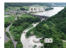
土砂バイパストンネル
