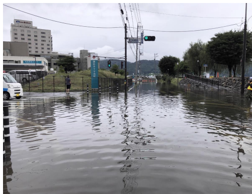
R3.8洪水による浸水状況(諏訪市)
