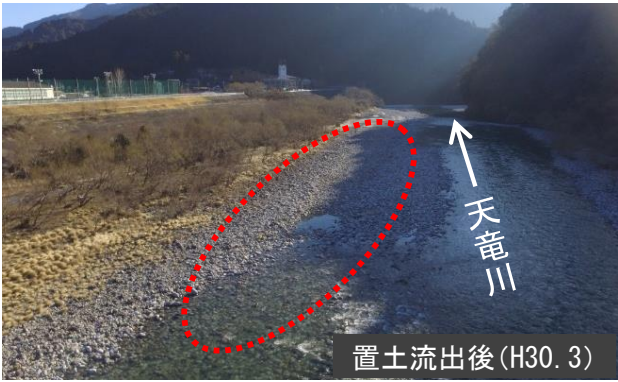
置土流出状況 (65.0k付近、約1万m 3 )
