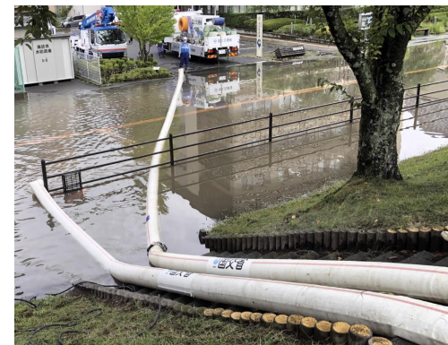
排水ポンプ車による排水状況
