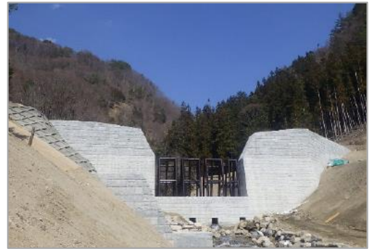
滝沢第2砂防堰堤 (大鹿村・中川村)
