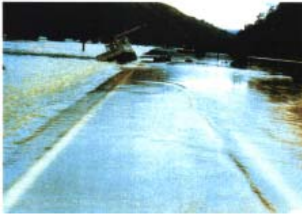
昭和 50 年 8 月洪水 (天塩川左岸 箴島左岸築堤の 溢水氾濫状況 音威子府村)
