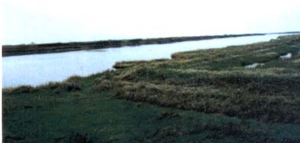
下流部の河道状況（天塩大橋左岸上流）
