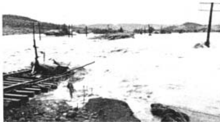
昭和 30 年 8 月洪水 (名寄川の洪水による鉄道流失状況)
