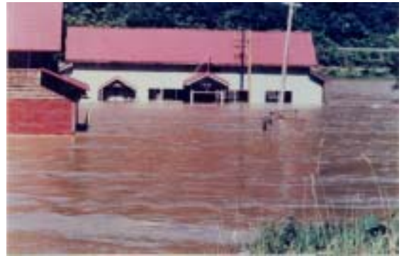
昭和 50 年 8 月洪水 (天塩川 音威子府村の浸水状況)
