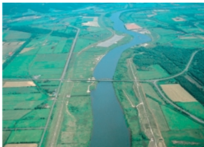
下流部の状況
