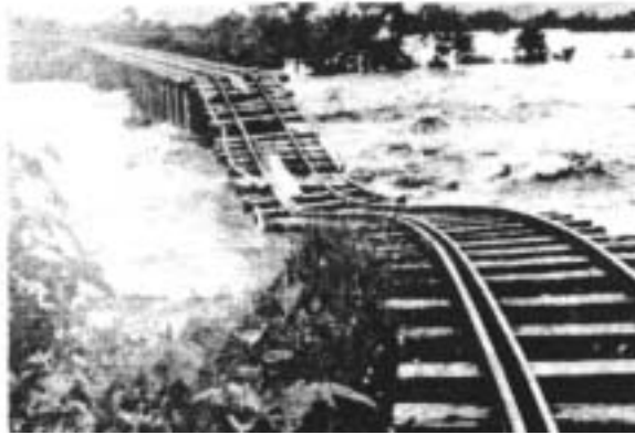
昭和 7 年 8 月洪水 ( 士別軌道天塩川九十九橋の流出 ) 出典：天塩川治水史
