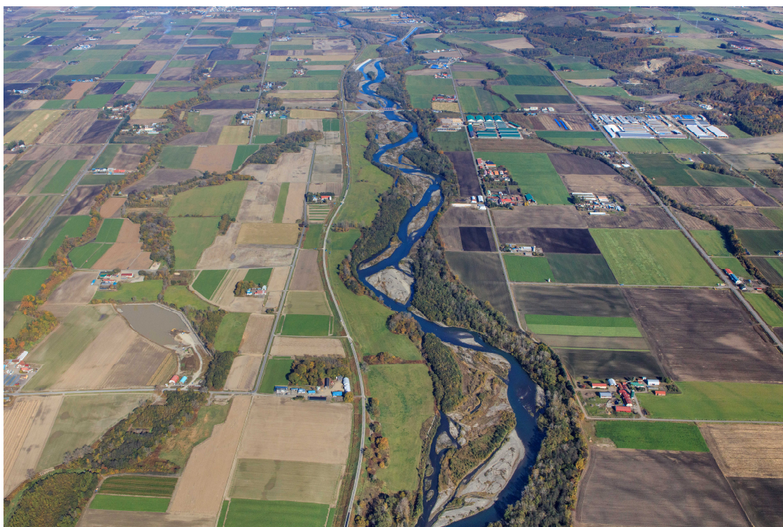
写真 2-7 十勝川上流 KP92 付近 (令和 2 年(2020 年)10 月撮影)
