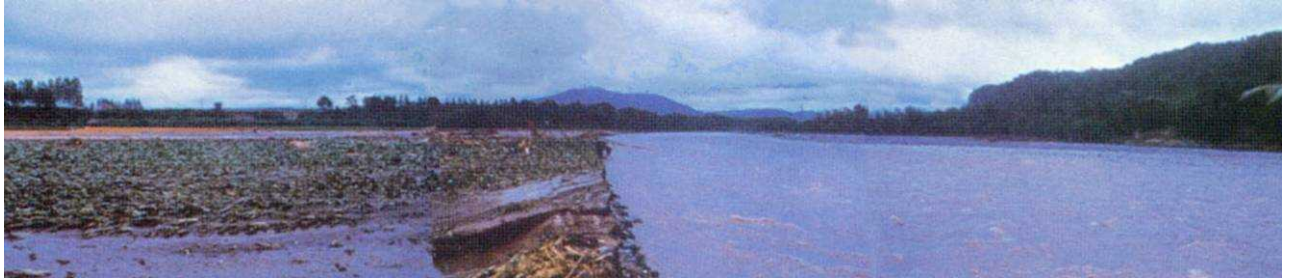
写真 4-4 十勝川の溢水氾濫による農地の被害状況（新得町屈足地区 くつたり ）
