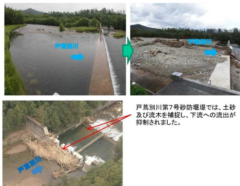
図 2-40 砂防堰堤での土砂や流木の捕捉状況
