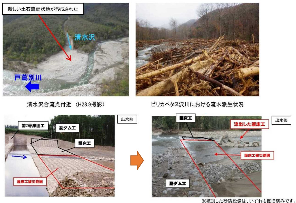
図 2-39 戸蔭別川での被害状況
