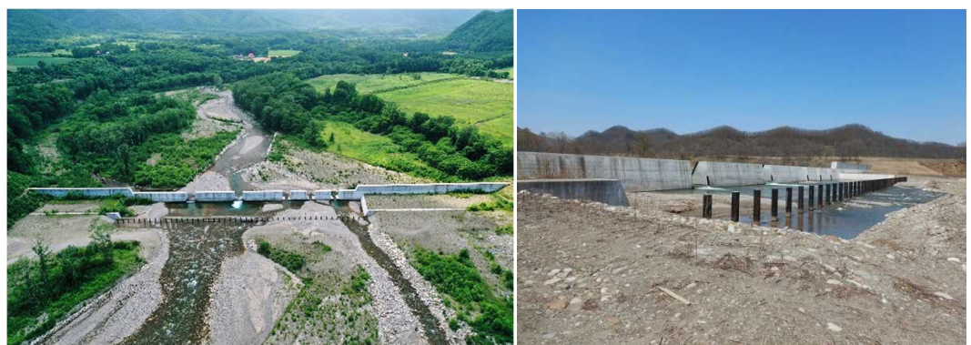
図 2-42 戸蔭別川第 2 号砂防堰堤（完成）
