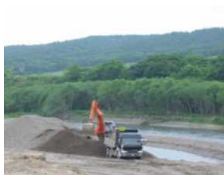
河道掘削した土砂を、
