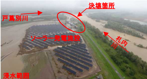
札内川 戸蔭別川合流付近 決壊後の状況(帯広市)
