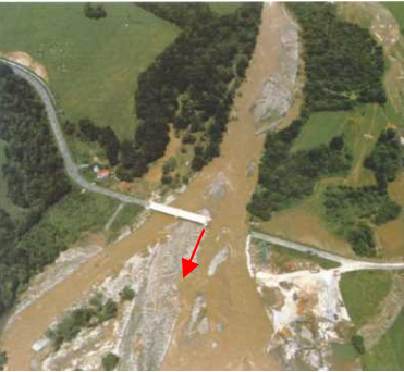
然別川 西瓜幕橋付近の被災状況(鹿追町)
