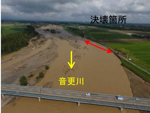
音更川 音和橋付近 決壊後の状況(音更町)
