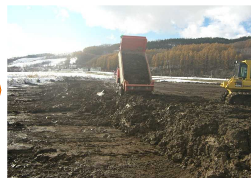
土砂が流出した農地へ運搬し、
