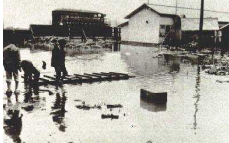
住宅街の浸水状況(芽室町)
