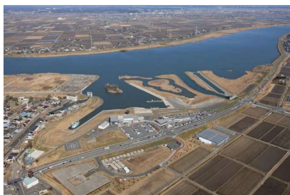
写真 8-20 さわら 佐原地区河川防災ステーション (利根川) (千葉県香取市)
