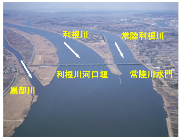
写真 1-9 利根川河口堰周辺 (約 19km)
