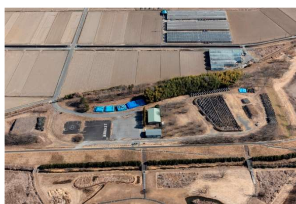
写真 8-23 もおか 真岡地区河川防災ステーション (鬼怒川) (栃木県真岡市)
