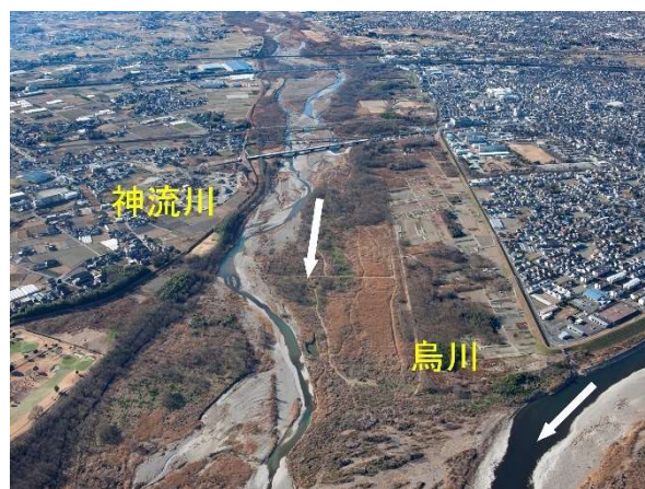
写真 1-14 烏川・神流川合流点（烏川約 3km）
