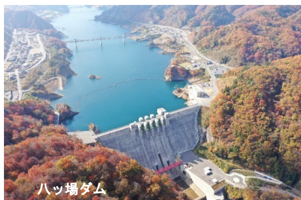
写真 4-42 ダム群の建設
