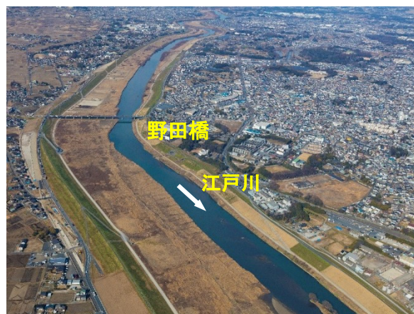
写真 1-16 野田橋付近 (約 39km)
