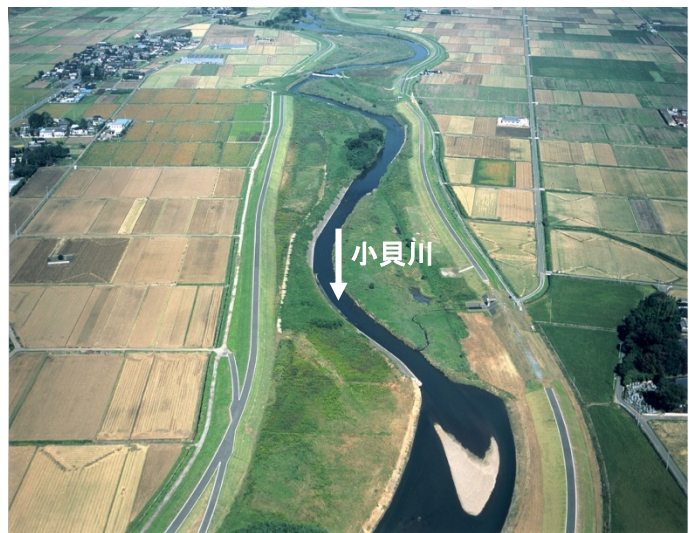
図 4-24 下館築堤工事（58.8～69.8km 区間）
