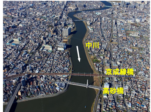
写真 1-36 京成線橋付近 (約 12km)
