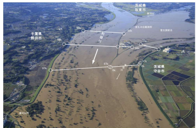
写真 4-37 鬼怒川・利根川合流点付近の状況
