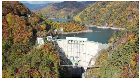
写真 8-11 かわまた 川俣ダム
