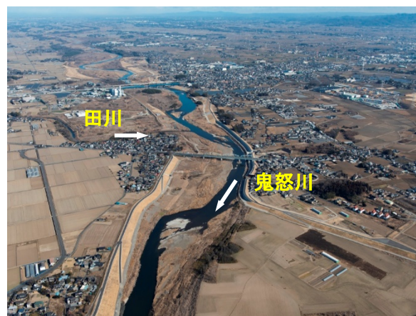
写真 1-24 田川合流点（約 44.5km）
