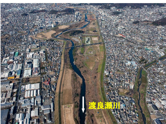
写真 1-21 岩井分水路地点（約 33km）
