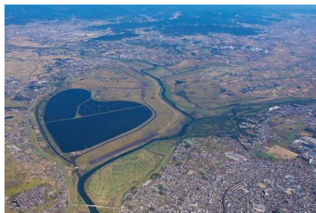
写真 4-41 渡良瀬遊水地の調節池化工事
