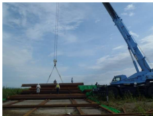
写真 8-19 平成 27 年 (2015 年) 関東・東北豪雨時の資機材の搬出状況 (新川通地区河川防災ステーション)
