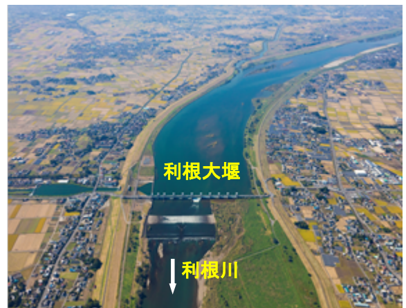
写真 1-4 利根大堰 (約 154km)
