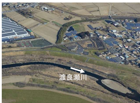
写真 8-22 おくど 奥戸地区河川防災ステーション (渡良瀬川) (栃木県足利市)
