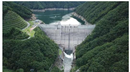
写真 8-13 ゆにしがわ 湯西川ダム
