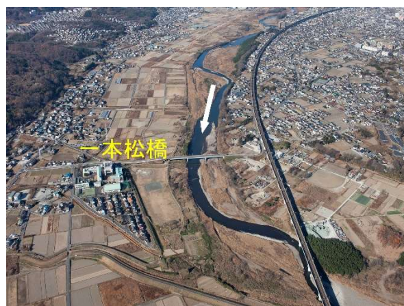
写真 1-12 一本松橋付近（烏川約 12km）
