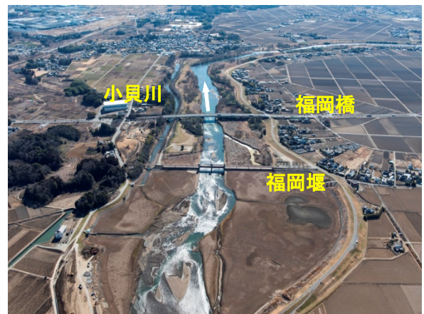
写真 1-28 福岡堰付近（約 27km）
