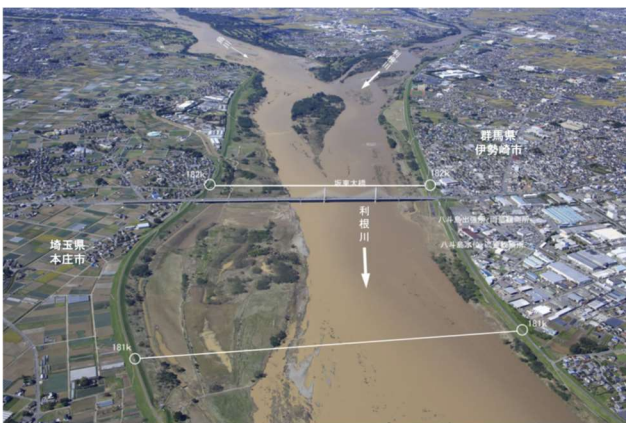
写真 4-36 烏川・利根川合流点付近の状況
