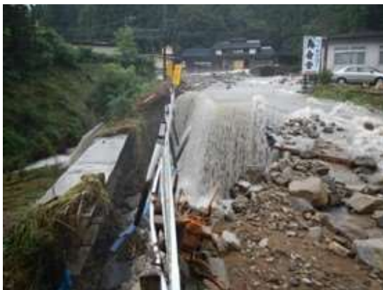
図 2-19 藤原地区における土石流被害
