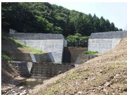
図 2-10 兎沢砂防堰堤
