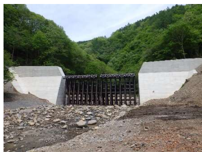
図 2-8 金山沢砂防堰堤
