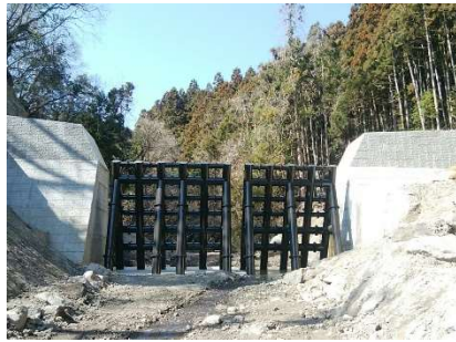
図 2-13 梨木川八号砂防堰堤
