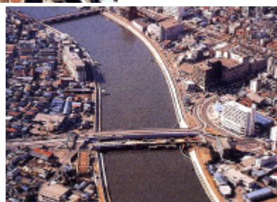
写真4-3-2 大規模浚渫後 (1.5k 付近)
