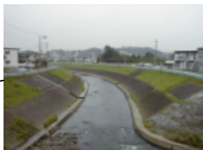
水車橋付近 (29km 上流側)
