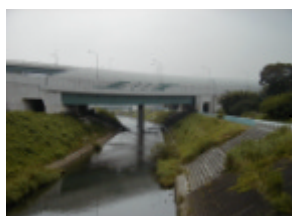
学校橋付近 (23km 上流側)
