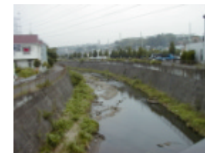
下川戸橋付近 (33km 上流側)
