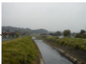
寺家橋付近 (28km 上流側)
