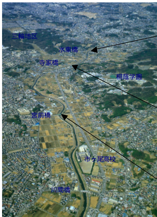
【25km 付近から上流の河道の状況】
