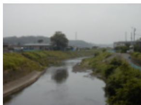
精進橋付近 (21km 上流側)
