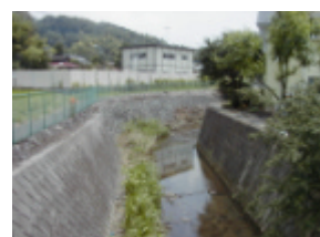
桜橋付近 (39km 上流側)
