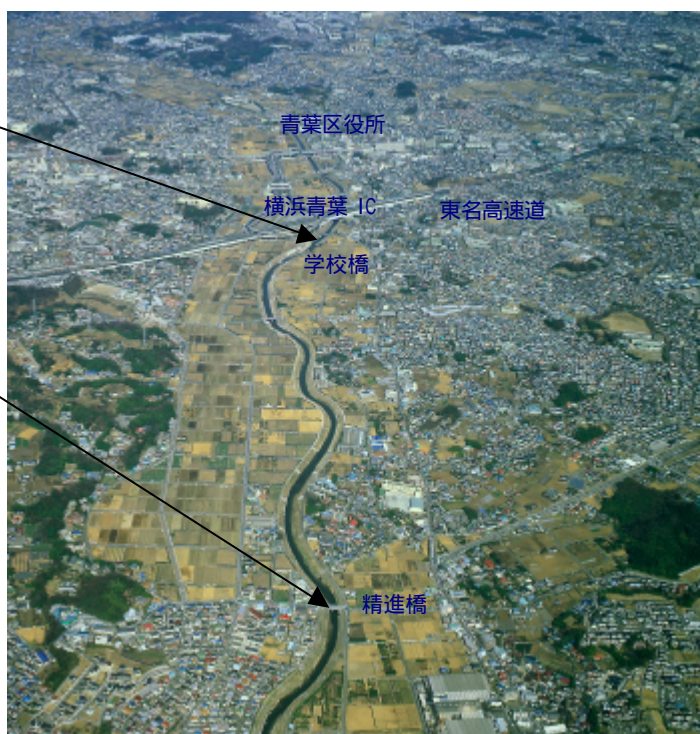
【20km 付近から上流の河道の状況】
