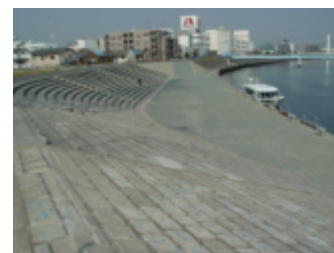
写真 9-4-2 佃野防災拠点 出典:京浜河川事務所
