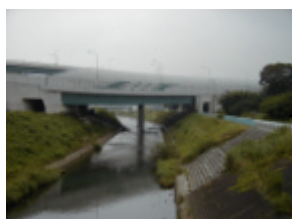
学校橋付近 (23km 上流側)
