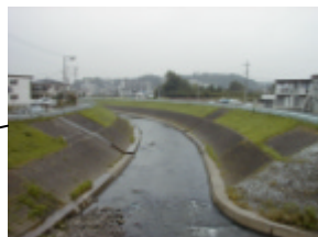
水車橋付近 (29km 上流側)
