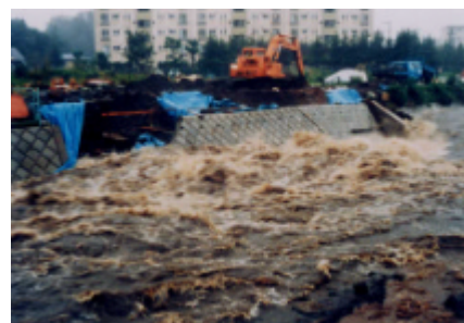
写真 4-2-4 昭和 57 年 9 月洪水 (上:鶴見川橋付近 下:青葉区恩田川) 出典:京浜河川事務所
