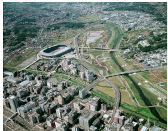
写真 4-3-3 鶴見川多目的遊水地 出典: 京浜河川事務所
