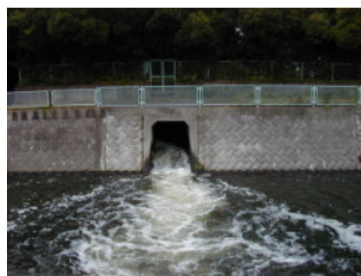
写真 6-3-1 成瀬クリーンセンター (町田市)からの放流状況
