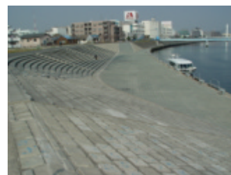
写真 9-4-2 佃野防災拠点 出典 京浜河川事務所
