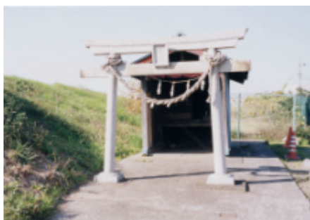
写真 2-3-2 川向堰周辺の水神社 出典：京浜河川事務所
