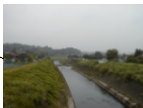
寺家橋付近 (28km 上流側)
