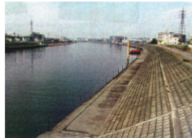
写真 2-2-2 下流部のコンクリートと矢板の護岸（6k 付近）
