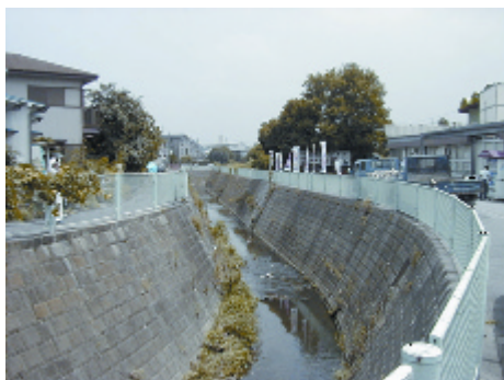
写真 2-1-4 コンクリートブロック護岸 (支川) 出典 :京浜河川事務所
