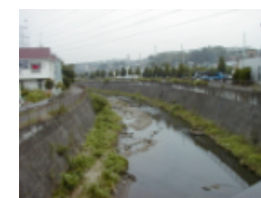
下川戸橋付近 (33km 上流側)
