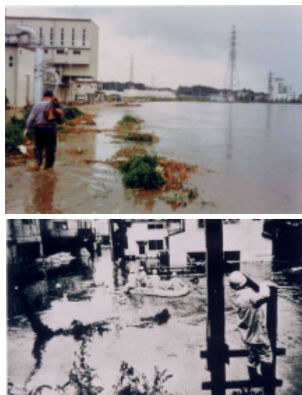
写真 4-2-3 昭和 51 年 9 月洪水 (上) 港北区大豆戸町地先の越水状況 (下) 大熊川の破堤による浸水状況) 出典: 京浜河川事務所
