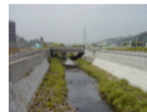
袋橋付近 (35km 上流側)
