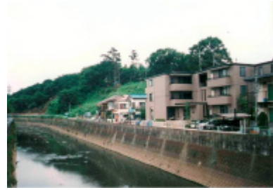
写真 2-2-1 高低差のある急傾斜のコンクリート護岸（支川矢上川）
