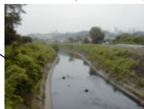
宮前橋付近 (26km 上流側)
