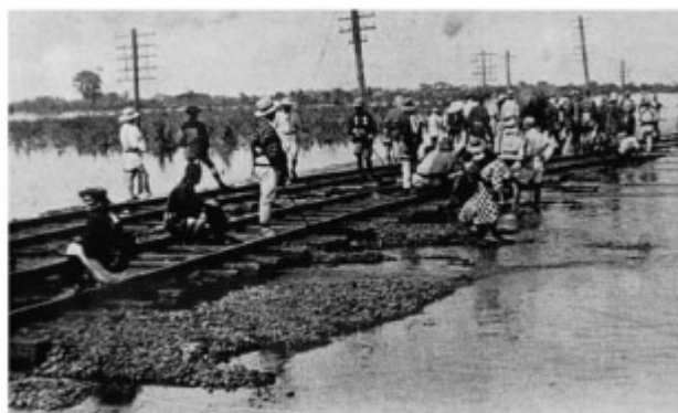
写真 4-1-1 明治 43 年 8 月 鶴見川の大洪水 出典：鶴見川流域誌 / 河川編、京浜河川事務所
