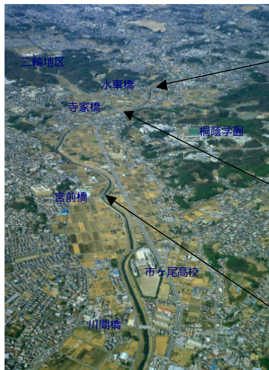
【25km 付近から上流の河道の状況】
