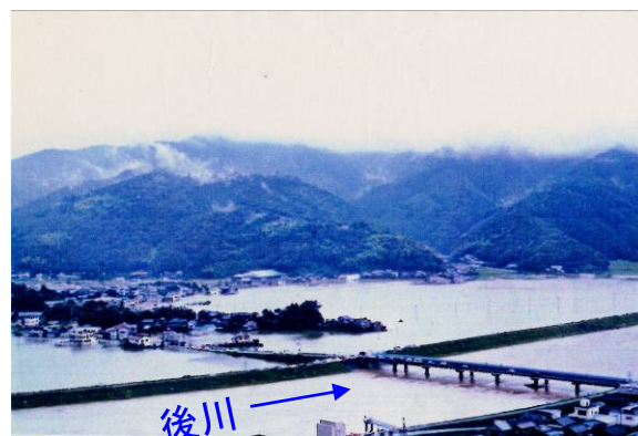
後川橋付近の状況
