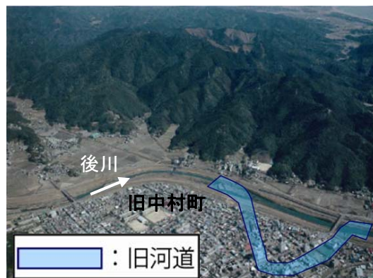
後川 佐岡地先の河道屈曲部の付替
