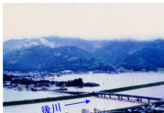
後川橋付近の状況
