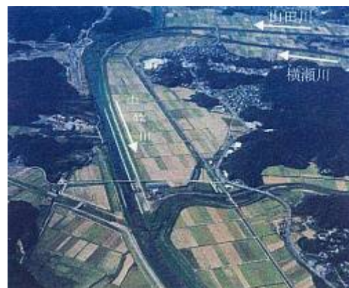
中筋川 15k 付近
