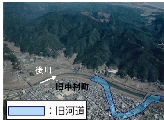
後川 きおか 佐岡地先の河道屈曲部の付替
