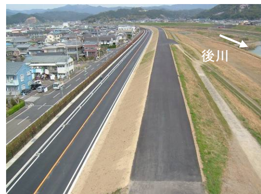
後川 中村堤防
