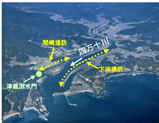
下田堤防・間崎堤防
