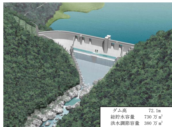
横瀬川ダム（建設中）
