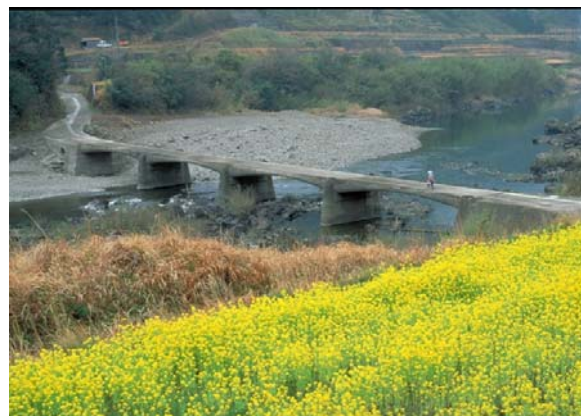
上岡沈下橋 (100k 付近)
