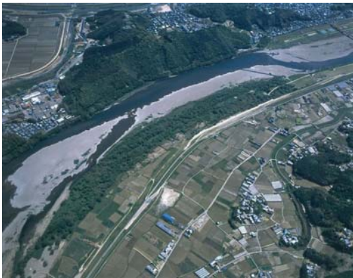
入田地区（下流方向を望む）
