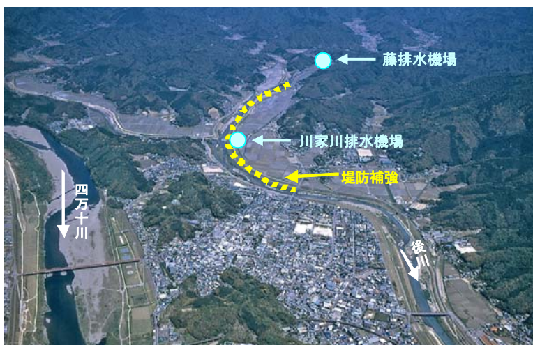
後川床上浸水対策特別緊急事業
