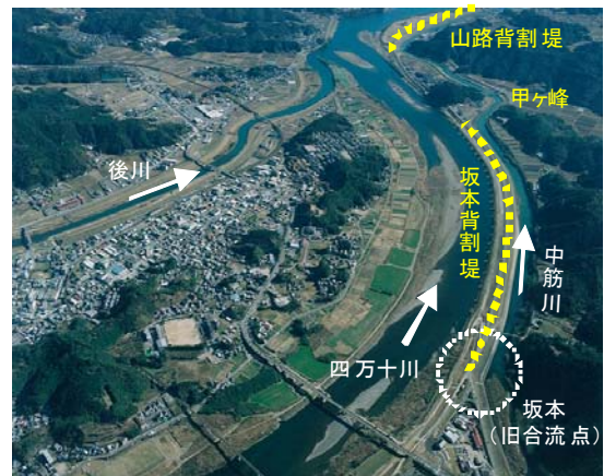
中筋川の改修
