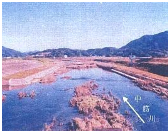
中筋川 5k 付近
