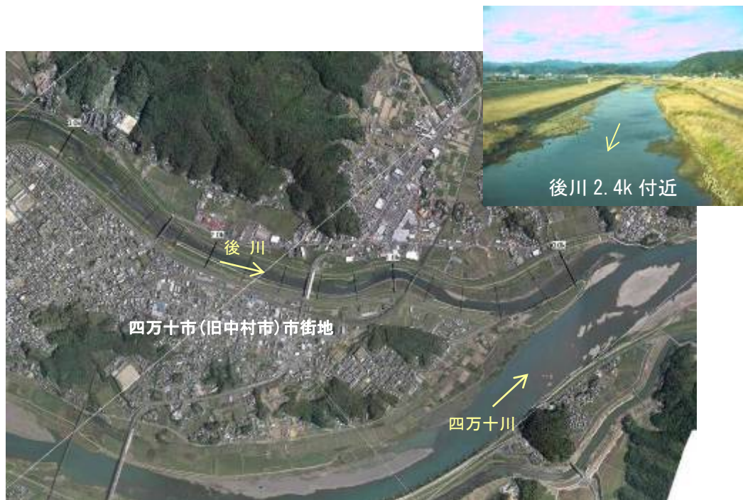
後川合流点付近
